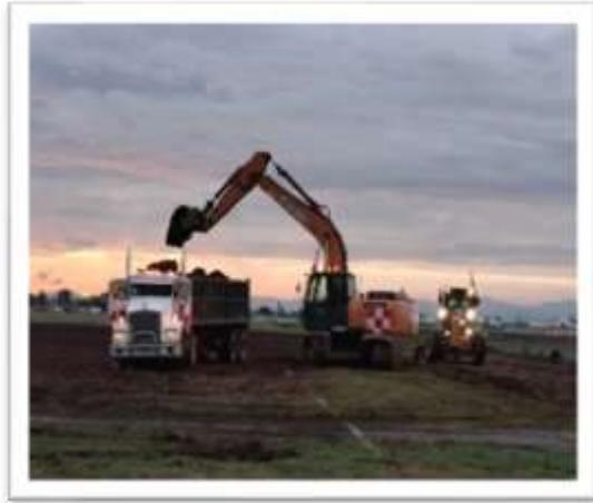
Debido a que en esta pista 05R-23L hay zonas de encharcamiento, será necesario reubicar la posición del sistema de drenaje existente en todo lo largo de la pista.
