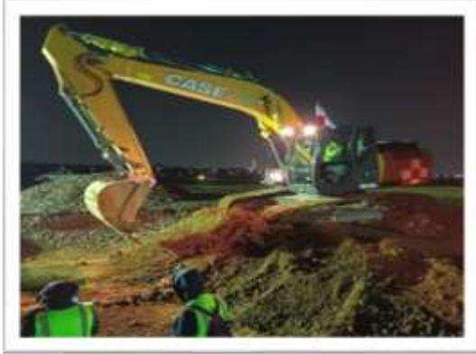
En 2024, iniciaron los trabajos para la rehabilitación de la pista 05R-23L que consisten en el corte y reposición de carpeta asfáltica existente de 10 cm, tanto en el tercio central como en los tercios laterales y de 6 cm en los márgenes, con base a lo establecido en el proyecto geométrico.
