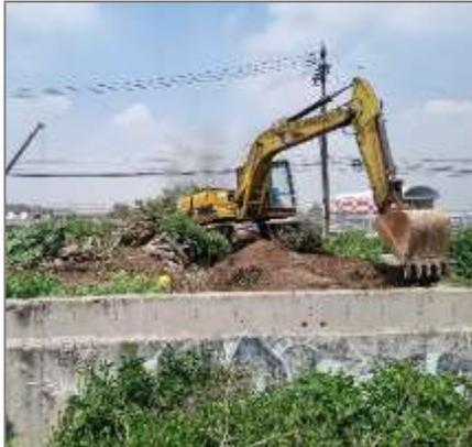
Consiste en la implementación de una línea de drenaje alterna en zona operacional, ante la pérdida de capacidad del flujo de drenaje con el que actualmente se cuenta (flujo por gravedad), así como por los asentamientos diferenciales del terreno que provocan contrapendientes, depresiones y hundimientos provocando fracturas y fisuras de la tubería de concreto reforzado del drenaje del aeropuerto.
