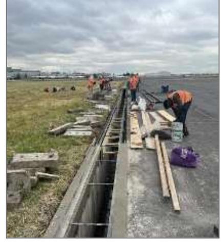
Trabajos en calle de rodaje E2 y pista 05R-23L para conformar el terreno y solucionar los encharcamientos provocados por la lluvia.
